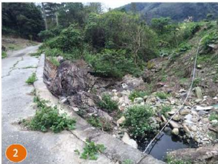
說明:A工區-106.10.16 豪雨既有涵管遭土砂堵塞,造成土砂及逕流溢流,危及部落安全
