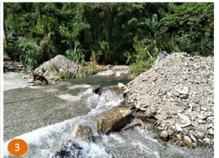
說明:A工區-106.10.16 豪雨既有涵管遭土砂堵塞,造成土砂及逕流溢流,危及部落安全
